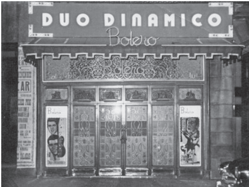
La sala Bolero, en Barcelona (1960).
