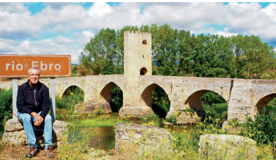
Pont medieval. Frías.
