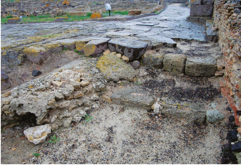
Las distintas partes de la construcción de una vía romana se observan en esta fotografía de Nora (Cerdeña). Fotografía de Jorge García Sánchez.
