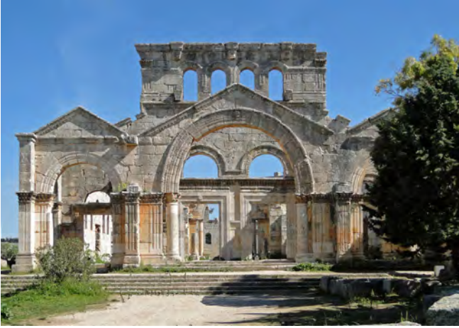
Fachada sur de la iglesia de San Simeón Estilita (c. 389-459), en Qal'at Sem'an («Castillo de Simón», en árabe). Combina la planta basilical y radial.
